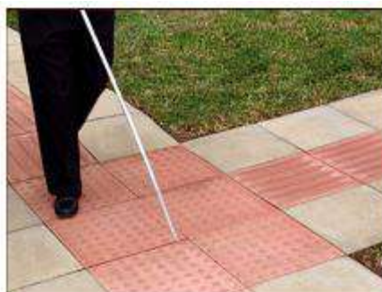
Figura 6: Foto piso Podotátil alerta e direcional
