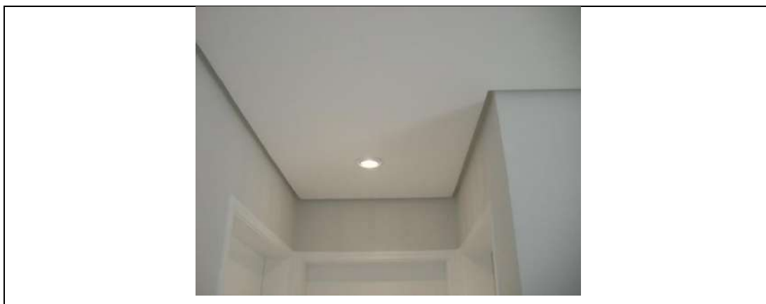
Figura 8: Detalhe do negativo de gesso
