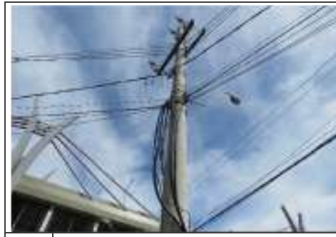
2 A foto mostra cabos da mufla estacionados sobre o cabo de fibra.
