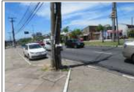
2 A foto mostra situação do poste danificado.
